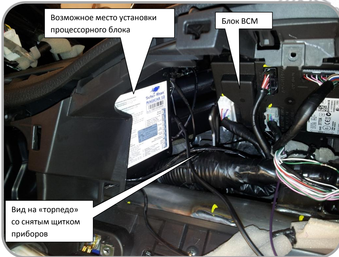
Рисунок 10. Установка процессорного блока
