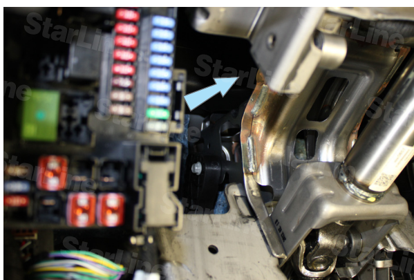
Фото 5. Место установки блока сигнализации
