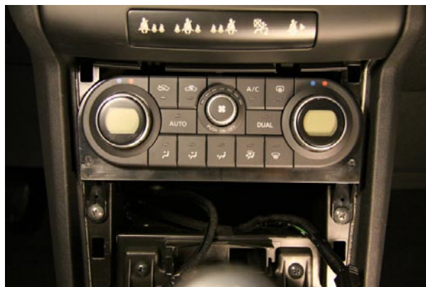
Фото 2.1. Демонтаж облицовки климат-контроля
