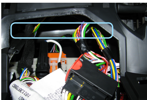
Фото 9. Место установки основного блока
