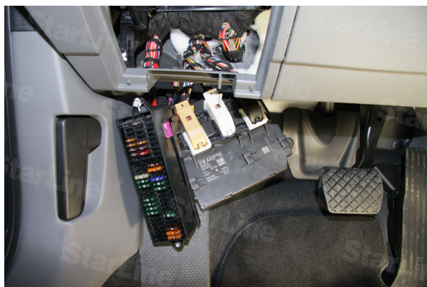
Фото 1.5. Блок предохранителей и блок BCM демонтированы
