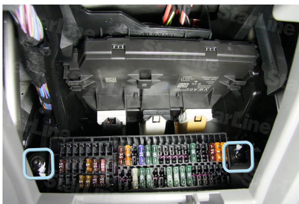
Фото 1.4. Болты крепления блока предохранителей
