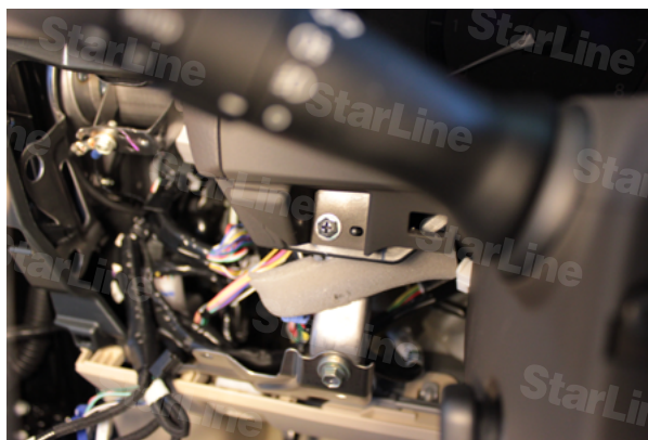
Фото 2.1. Саморез накладки щитка приборов
