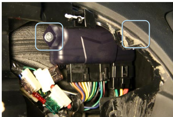
Фото 7. Крепление блока сигнализации
