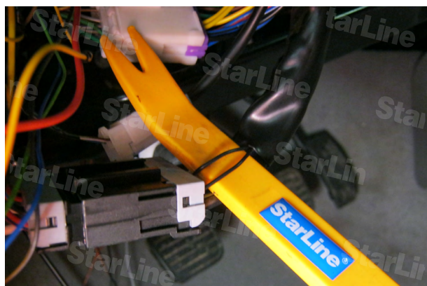
Фото 9. Провода антенны штатного иммобилайзера (черные)
